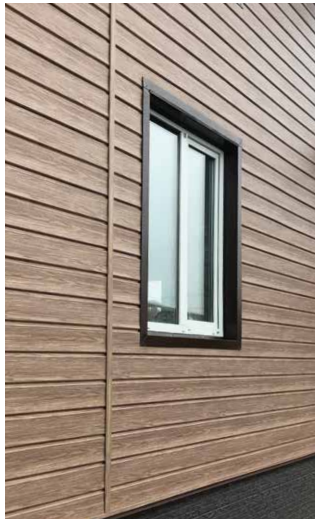
Пример монтажа сайдинга серии LUX под дерево
